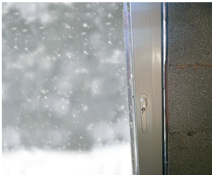
Das Band ist auf Grund der Kälte nicht expandiert
